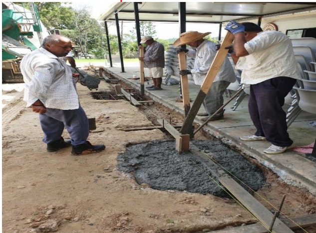
First concrete pour
